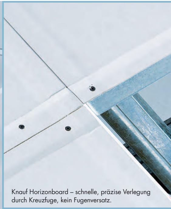
Ohne breites Ausspachteln. Fugendeckstreifen Kurt einfach kreuzweise durchlaufen lassen
