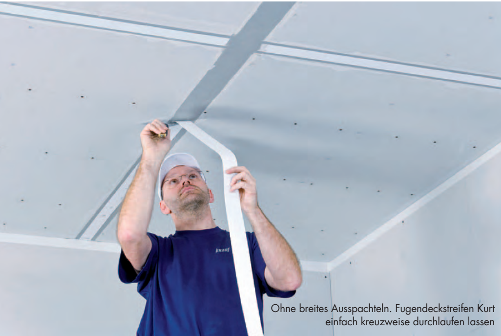
Knauf Horizonboard – schnelle, präzise Verlegung durch Kreuzfuge, kein Fugenversatz.
