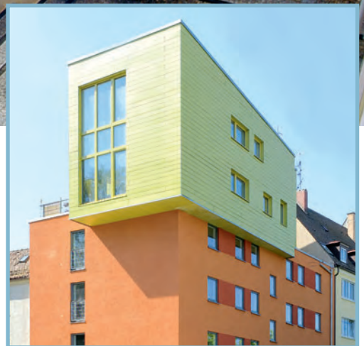
Einsatz von Diamant-Platten bei der Sanierung und Penthouse-Aufstockung in Holzbauweise. Das Diamant-Trockenbausystem wirkt dabei statisch aussteifend.
